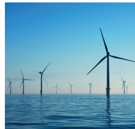
Site éolien offshore de Saint-Nazaire
