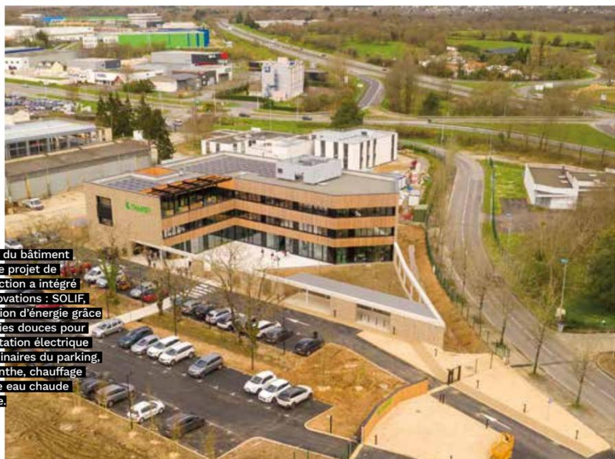
Au-delà du bâtiment passif, le projet de construction a intégré nos innovations : SOLIF, production d'énergie grâce aux voiries douces pour l'alimentation électrique des luminaires du parking, et Helianthe, chauffage de notre eau chaude sanitaire.
