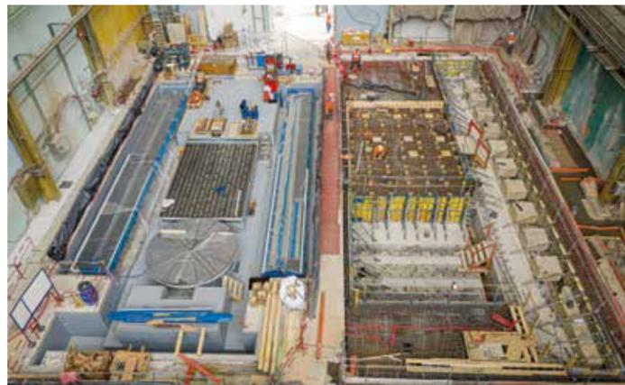
Naval Group a confié à nos équipes Génie Civil la réalisation de massifs en béton armé pour ses 3 nouvelles machines. Ces outils sont destinés à l'usinage, au micron, de pièces pour les bâtiments de défense. En seulement 8 mois, les équipes ont relevé le défi : 5 000 m<sup>3</sup> de béton et roche à extraire, 800 m<sup>2</sup> de soutènement, 500 réservations à poser pour permettre l'ancrage des machines, 5 000 m<sup>3</sup> de béton à couler. Le tout dans un site sensible et en exploitation.
