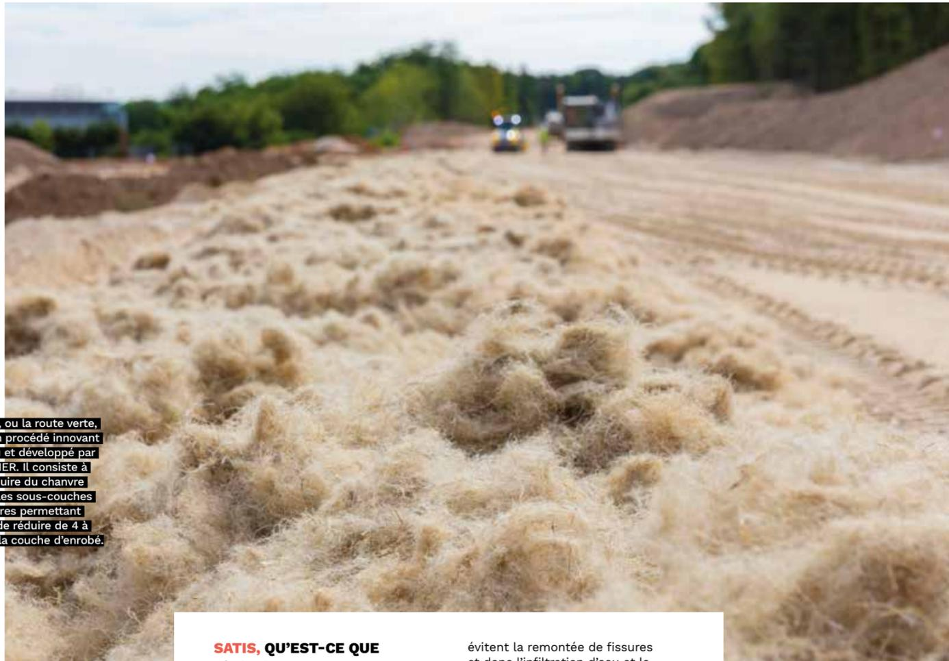
SATIS, ou la route verte, est un procédé innovant conçu et développé par CHARIER. Il consiste à introduire du chanvre dans les sous-couches routières permettant ainsi de réduire de 4 à 5 cm la couche d'enrobé.
