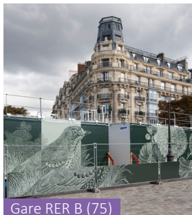
Vérinage Pont de Rungis (94)
